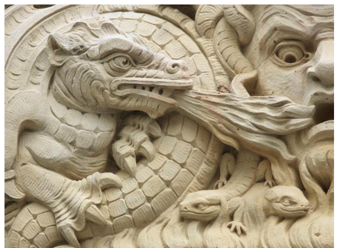
Detailansicht Goethe Gymnasium in Berlin nach Beendigung der Fassadensanierung Natursteinarbeiten; Foto: Falko Behr
